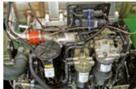
Filtre à particules
